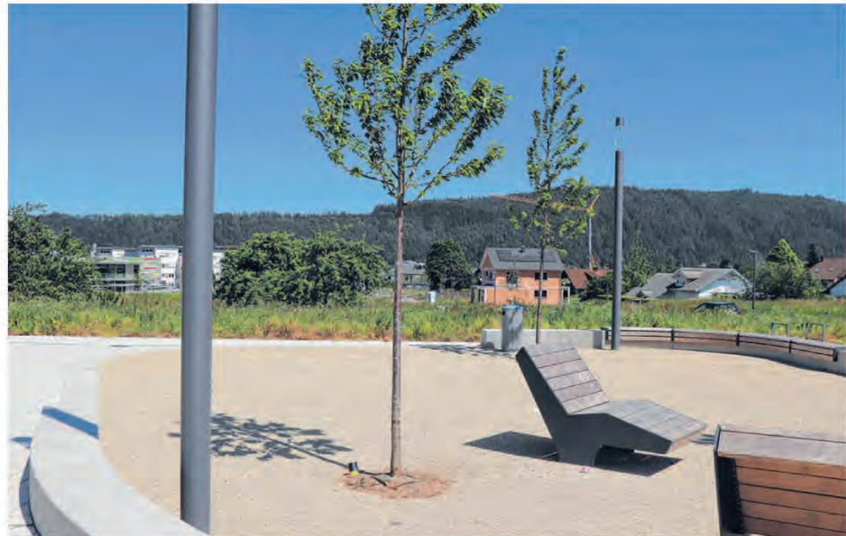
Der Quartiersplatz ist fertig. Bis die Geschosswohnungen gebaut werden, dauert es allerdings noch ein bisschen.
